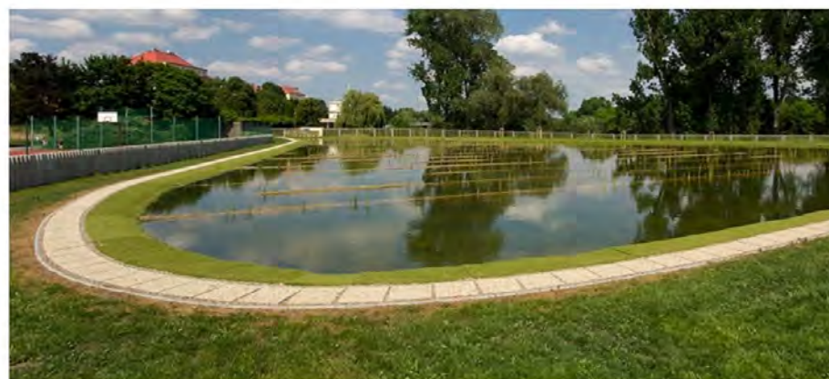
Referenční projekt – Biotop Radotín se nachází v městské části Prahy 5. Projekt biotopu je v rámci Prahy a okolí ojedinělý. Podstata biotopu spočívá v biologickém způsobu udržování čisté vody, bez chemie, za působení vodních rostlin a přírodních ekosystémů ve filtračních lagunách. K zajištění optimální filtrace přes biologickou část, bylo nutné její plochu rovnoměrně osadit druhovým složením rostlin.
